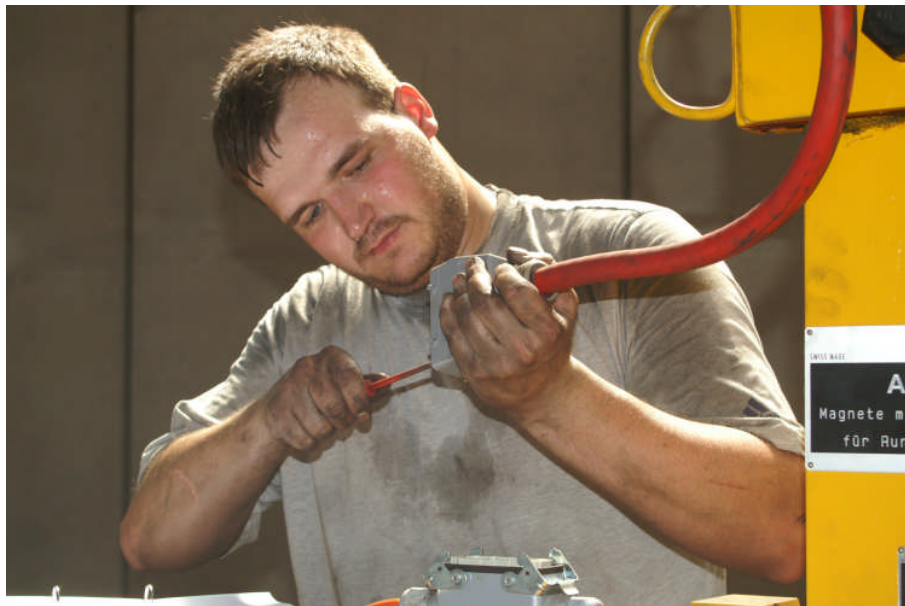
Figure 2: Prüfung und Wartung einer Steckverbindung
